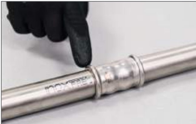
Controllo della pressatura / Checking the press connection
