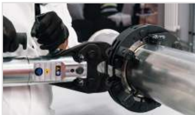
Assemblaggio pressatura n°1 / Press assembly phase 1
